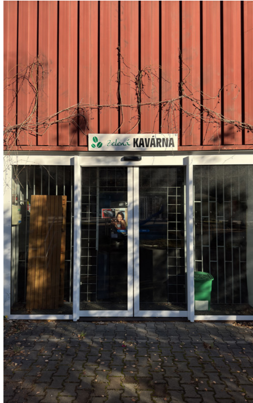
detail fasády pavilonu G
