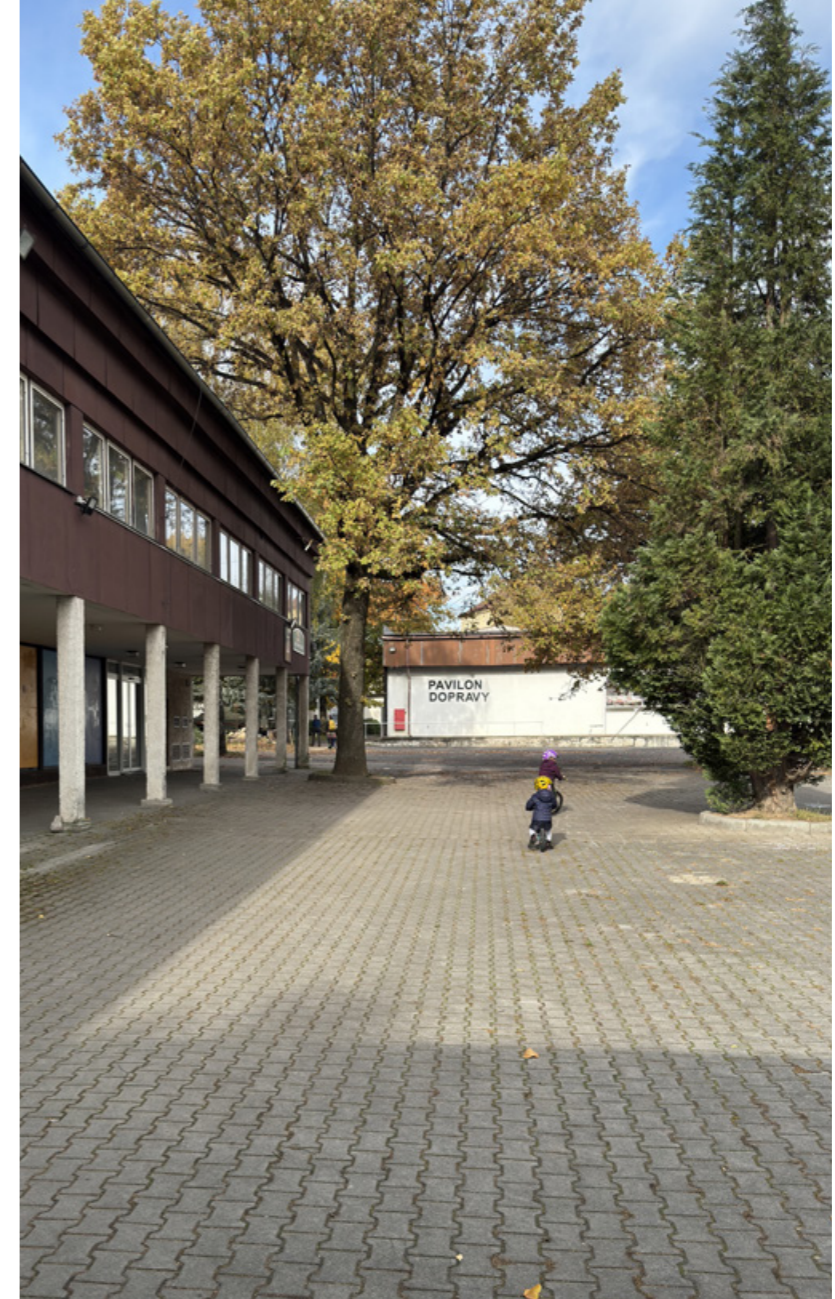
pohled na pavilon E, po levé straně pavilon I
