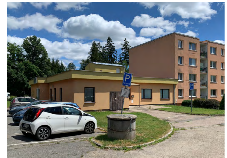
Obr. 32: Objekt "Medúzy" - bývalá posilovna, dnes ordinace lékařů, kanceláře a sklad stavební firmy
