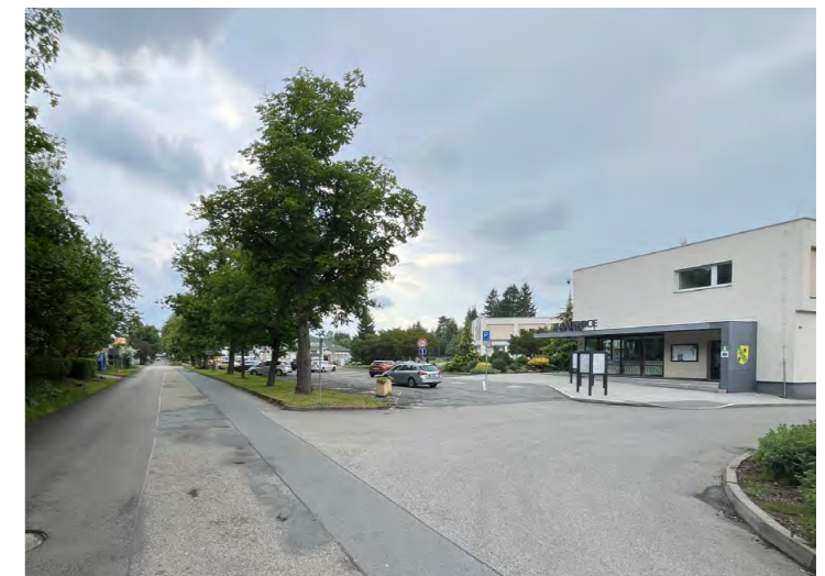
Obr. 25: Předprostor obecního úřadu směrem od Ringhofferovy ulice
