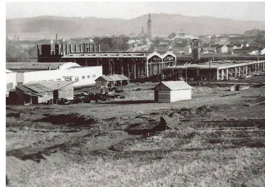
1949, stavba hal Jitexu na zelené louce u Otavy
