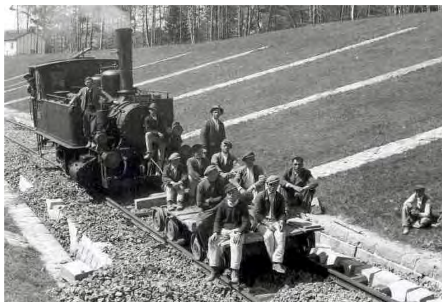
[45] Stavebný vlak pred jedným z tunelov trate Prešov – Strážske (1942)
