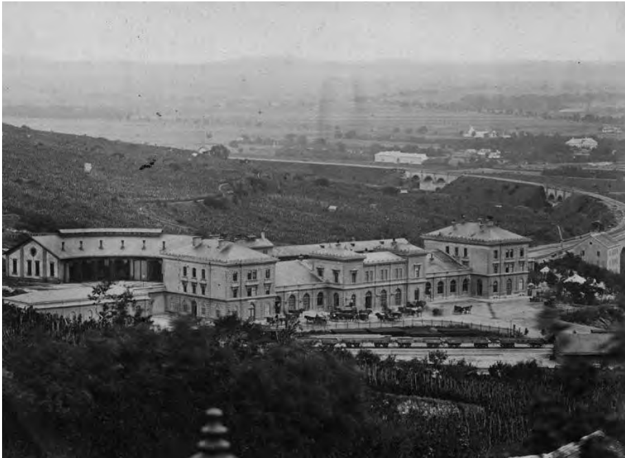
[42] Panoramatický pohľad na bratislavskú hlavnú železničnú stanicu (1890)
