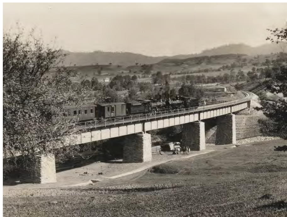
[44] Závažové skúšky jedného z mostov na trati Handlová – Horná Štubňa (1931)
