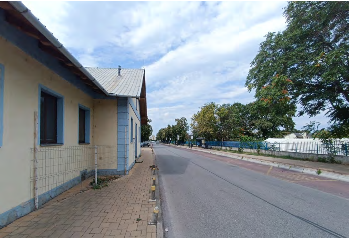
[34] Prístupová cesta ku stanici
