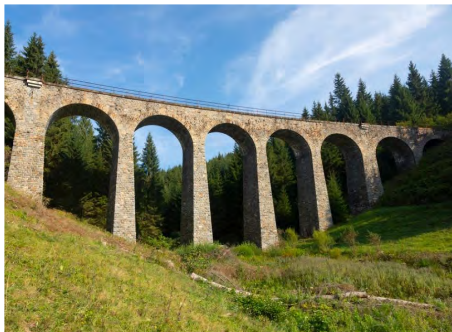
[46] Chmarošský viadukt, Telgártska slučka, stavba z roku 1933
