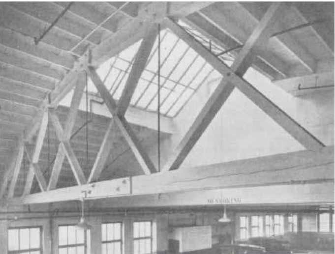
12 - Sears, Roebuck a společníci, Chicago, (1926) - dřevěné konstrukční řešení
