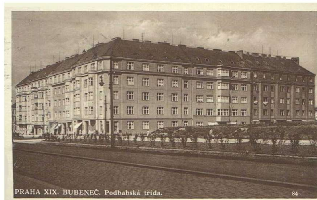
Původně Podbabská ulice nyní ulice Jugoslávských partyzánů [4]
