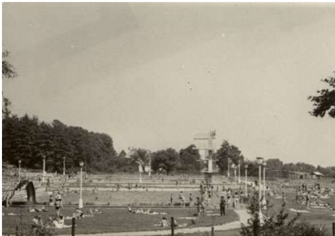
V 60. letech 20. století byl volný prostor východně od budovy Koldomu vyplněn oddychovým areálem s koupalištěm, doplněný tenisovými kurty a sportovní halou.
