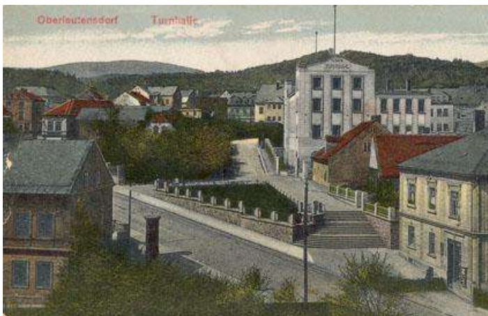
Ve střední části Rooseveltovy ulice byla počátkem 20. století postavena pro I. Deutsche Turnverien německá tělocvična s velkou zahradou a restauračním zařízením. Od 50. let 20. století byla budova známa jako ZK Benar. Snímek z doby kolem roku 1918.
