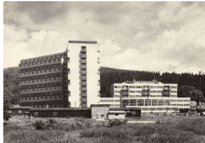
Koldům po dostavbě západního křídla a středové části s polyfunkčním vybavením v roce 1953. Hlavními autory projektu byli Václav Hlinský a Evžen Linhart.
