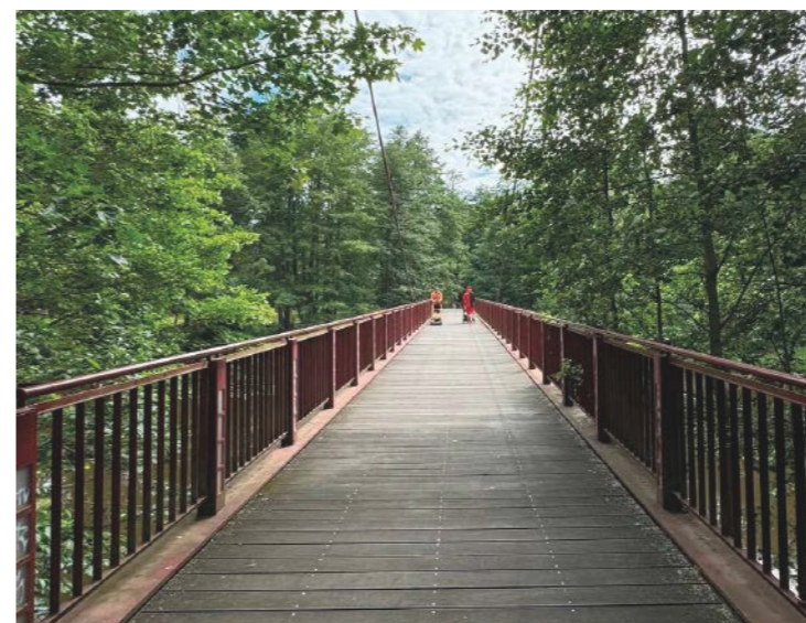
Dřevěná lávka přes řeku
