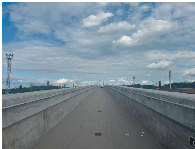
Lávka přes železniční trať
