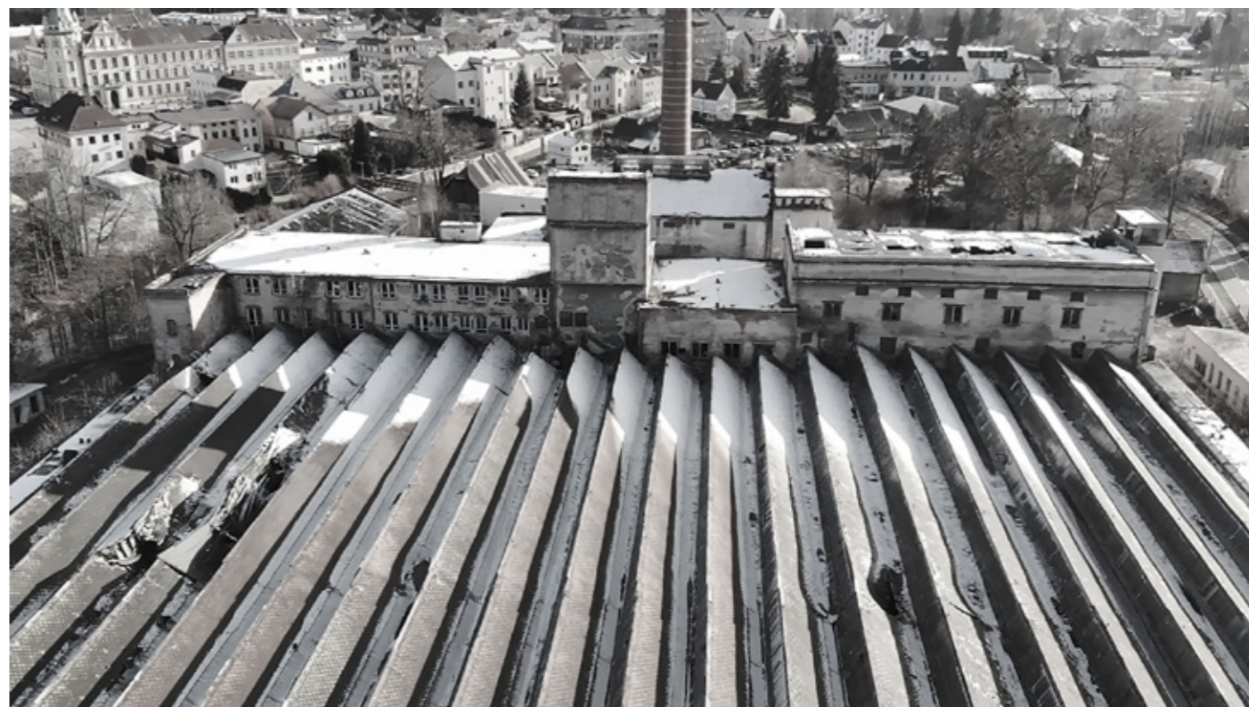
Aktuální stav areálu - detailnější pohled na severozápadní fasádu hlavní budovy
