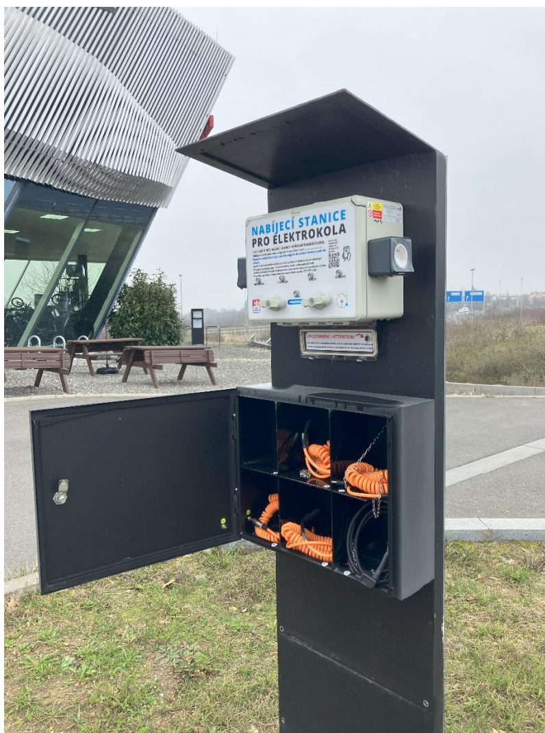
Obr. 15: Příklad dobíjecí stanice (bílá) typu wallbox. Stanici je možné umístit na sloupek (jako v případě tohoto obrázku), nebo také na stěnu budovy
