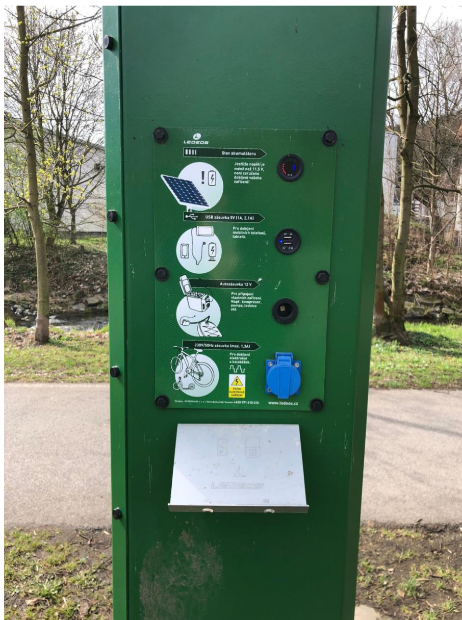
Obr. 17: Dobíjecí sloup od firmy Lederer – detail ovládacího panelu. Cyklista musí vozit nabíječku s sebou a dobíjení je pomalé. Pro celý stojan je použita pouze jedna zásuvka 230 V a dva USB sloty
