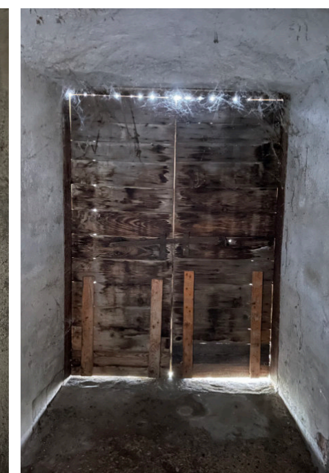
Dveře na severní fasádě
