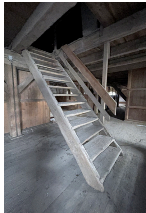
Schodiště do 4.NP
