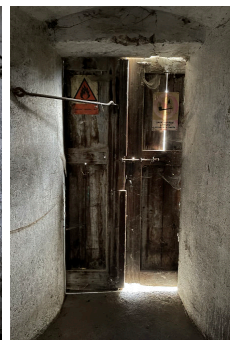
Dveře na jižní fasádě
