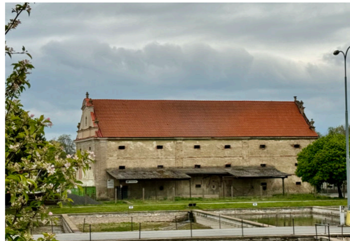
Pohled na jižní fasádu a rybárny
