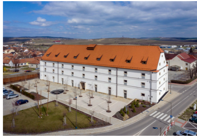
Obr. 15: Po rekonstrukci - pohled na západní fasádu
