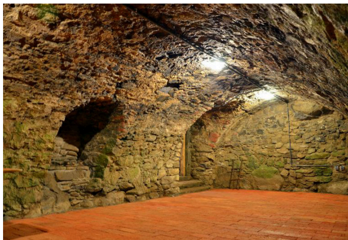
Obr. 25: Po rekonstrukci - sklep pod špejcharem
