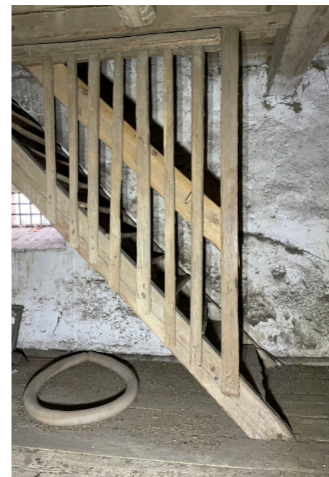
Schodiště do 3.NP
