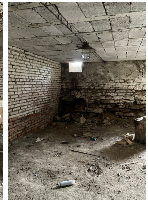
Severozápadní roh 1.PP
