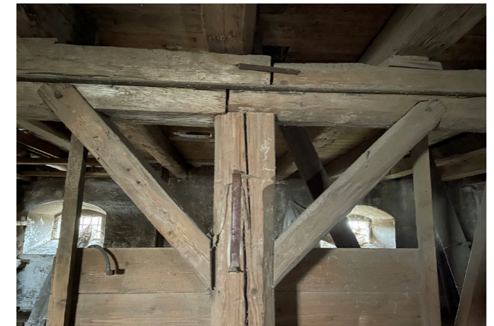
Nosný sloup a průvlak
