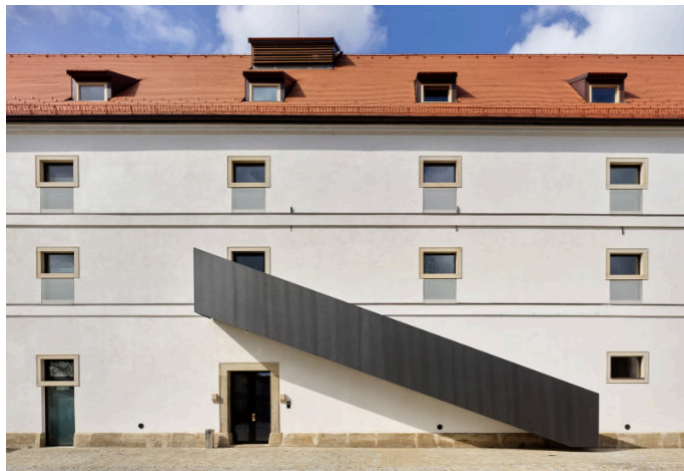
Obr. 18: Po rekonstrukci - pohled na východní fasádu
