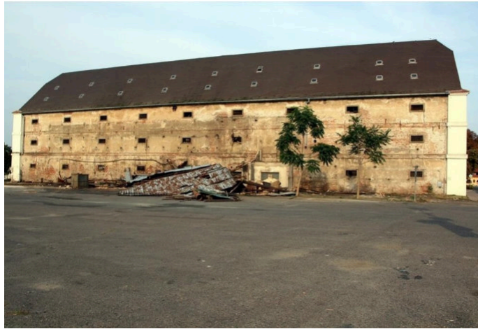
Obr. 14: Původní stav sýpky
