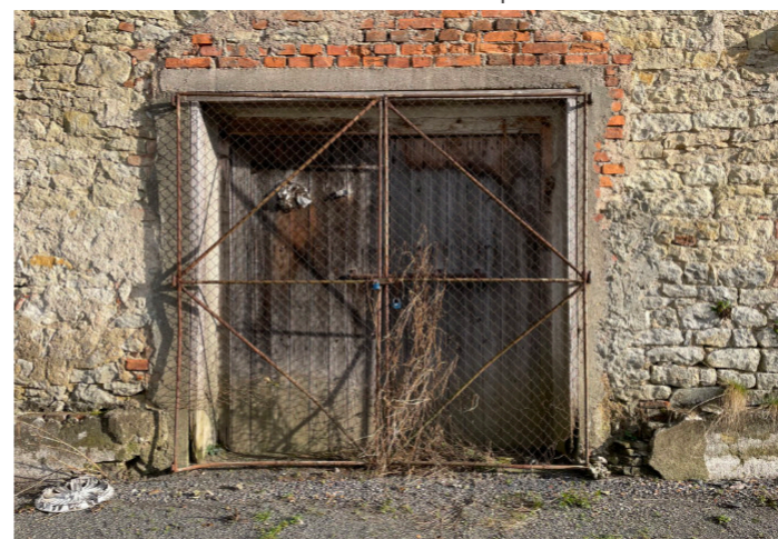
Dveře do 1.PP - severní fasáda
