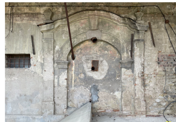
Portál - jižní fasáda
