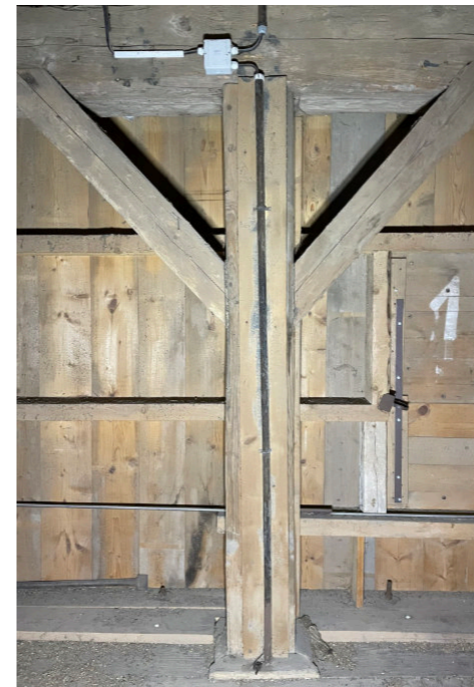
Nosný sloup a průvlak
