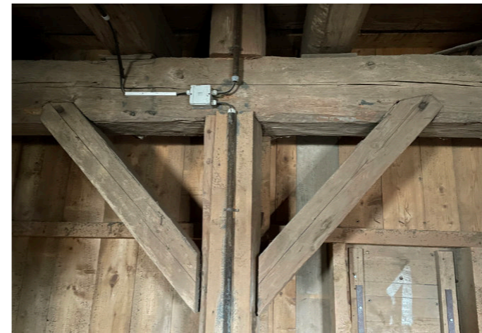
Nosný sloup a průvlak
