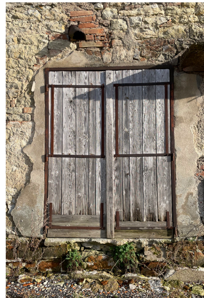
Dveře - severní fasáda
