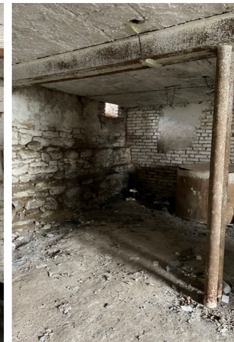
Ocelové sloupky a IPE profil
