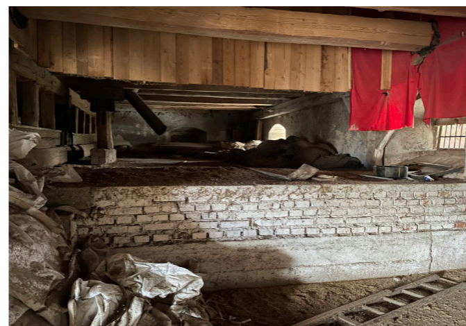
Zvýšená podlaha nad 1.PP
