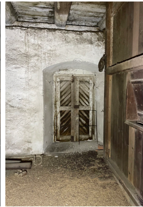
Dveře na jižní fasádě
