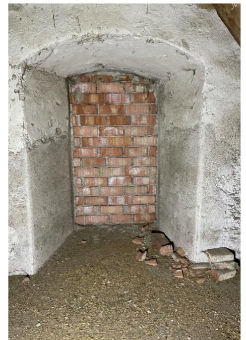
Zazděné dveře na západní fasádě
