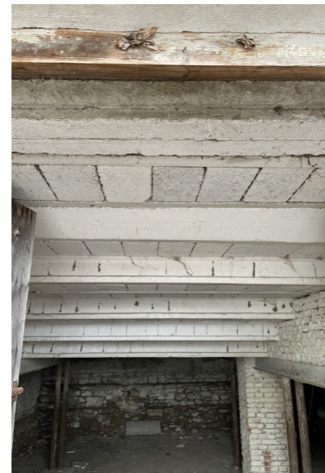
Pohled na strop
