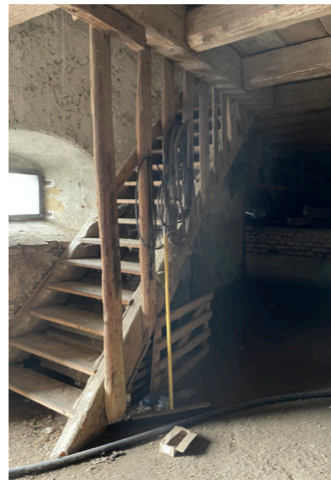
Schodiště do 2.NP
