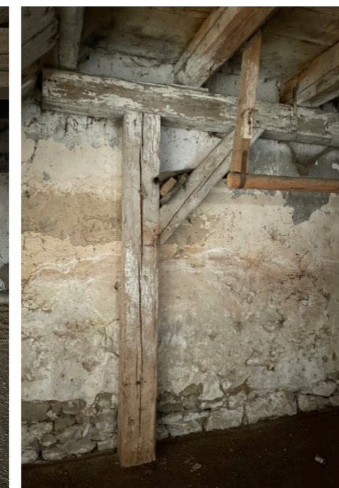
Nosný sloup a průvlak
