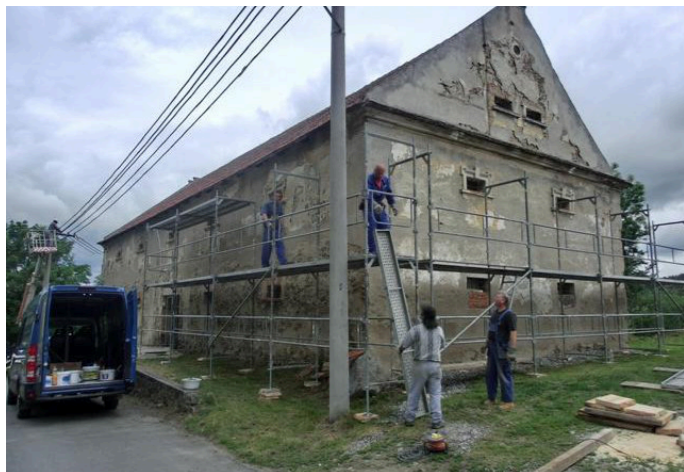
Obr. 23: Původní stav sýpky
