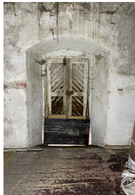
Dveře na jižní fasádě
