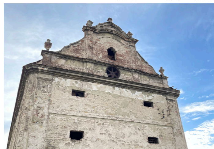
Štít - východní fasáda
