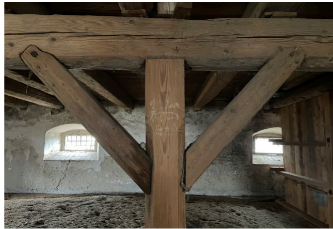
Nosný sloup a průvlak
