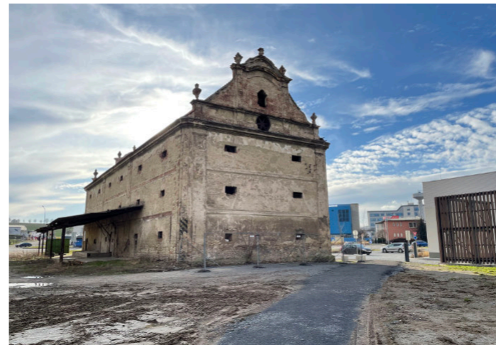
Pohled na východní fasádu
