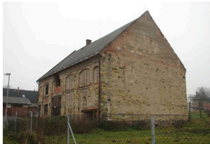
Obr. 20: Původní stav sýpky
