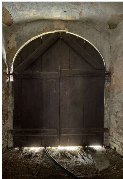
Pohled na vstupní dveře
