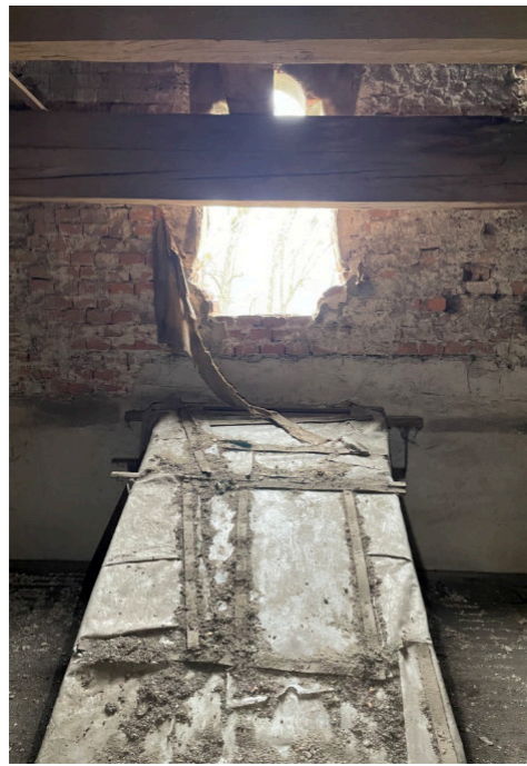
Okno na východní fasádě
