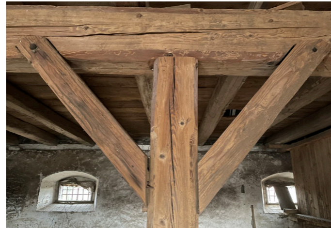
Nosný sloup a průvlak
