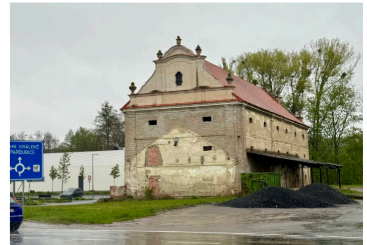
Pohled na západní fasádu
