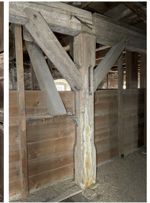
Nosný sloup a průvlak
