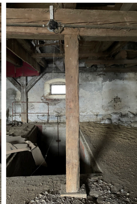
Nosný sloup a průvlak
