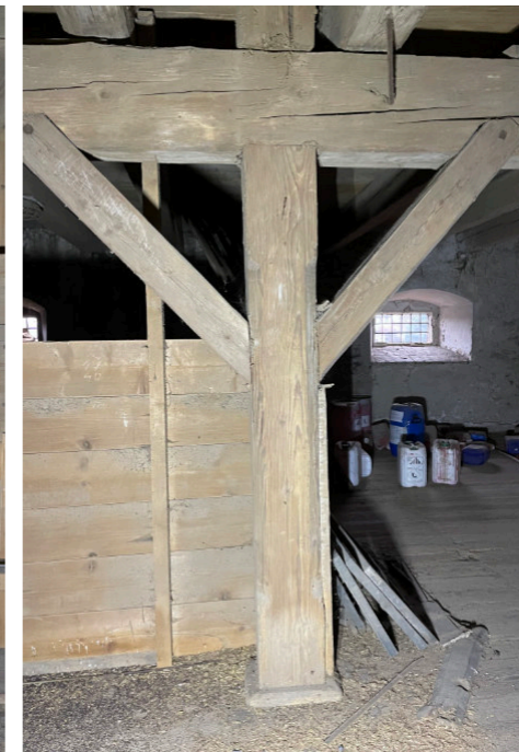
Nosný sloup a průvlak
