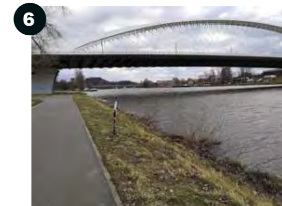
Obr.č. 125 Pohled na Trojský most z cesty, zdroj vlastní 2023
