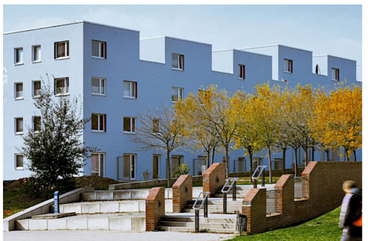
Stefan Forster Architekten_Leinefelde_Německo_2007_před a po
