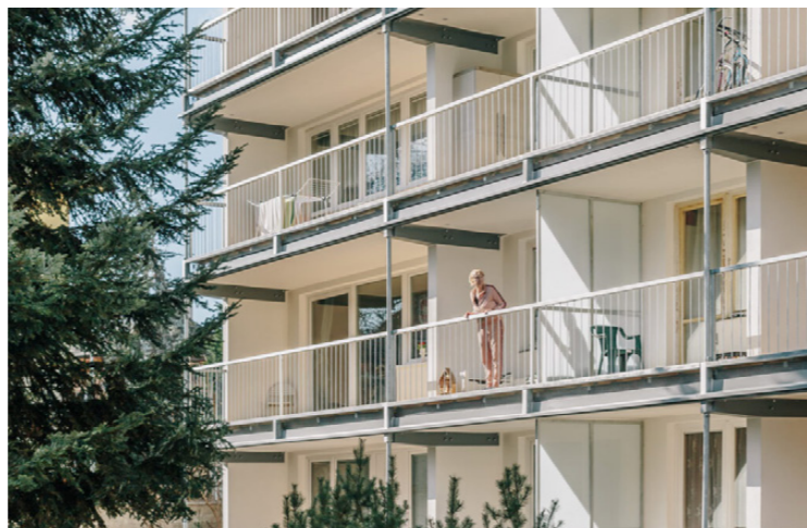
Rozšíření lodžii panelového domu_RE:architekti_2022
