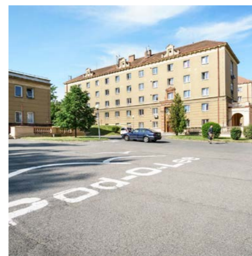
komplex kolejí ČVUT
