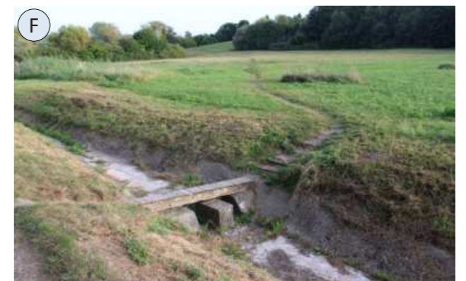
obr. 95: Přejechod přes trativod u studánky Pod Rozárkou vlastní foto
