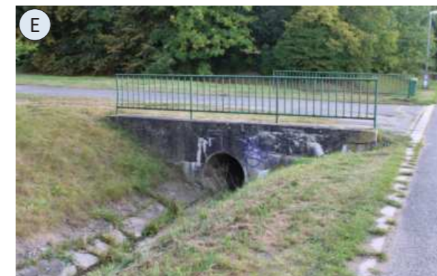
obr. 94: Přejechod přes trativod, zatrubněné koryto vlastní foto
