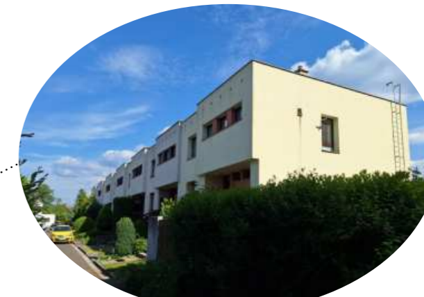
obr. 103: Zástavba řadová jednotná vlastní foto
