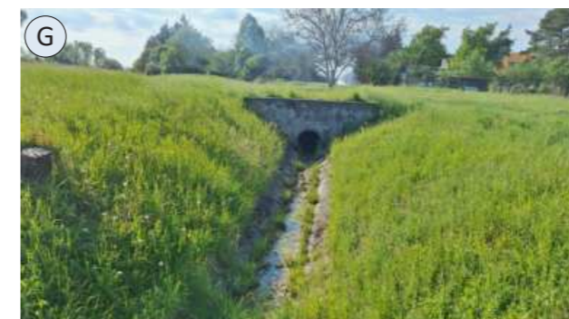
obr. 96: Přejechod přes trativod, zatrubněné koryto vlastní foto
