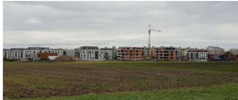
obr. 51: Pohled na východní část Moravského Předměstí, v popředí nová výstavba vlastní foto
