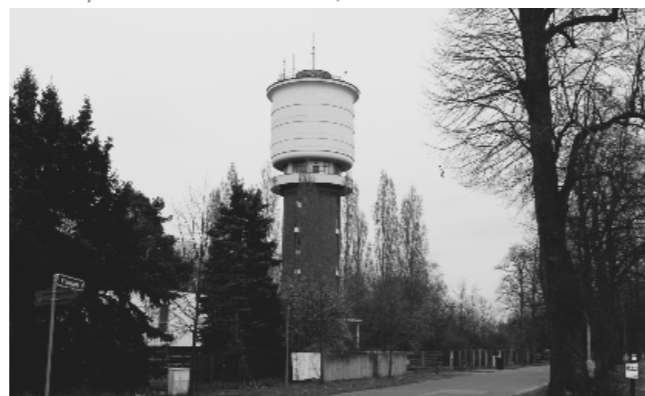
obr. 38: Věžový vodojem na Kopci sv. Jana vlastní foto
