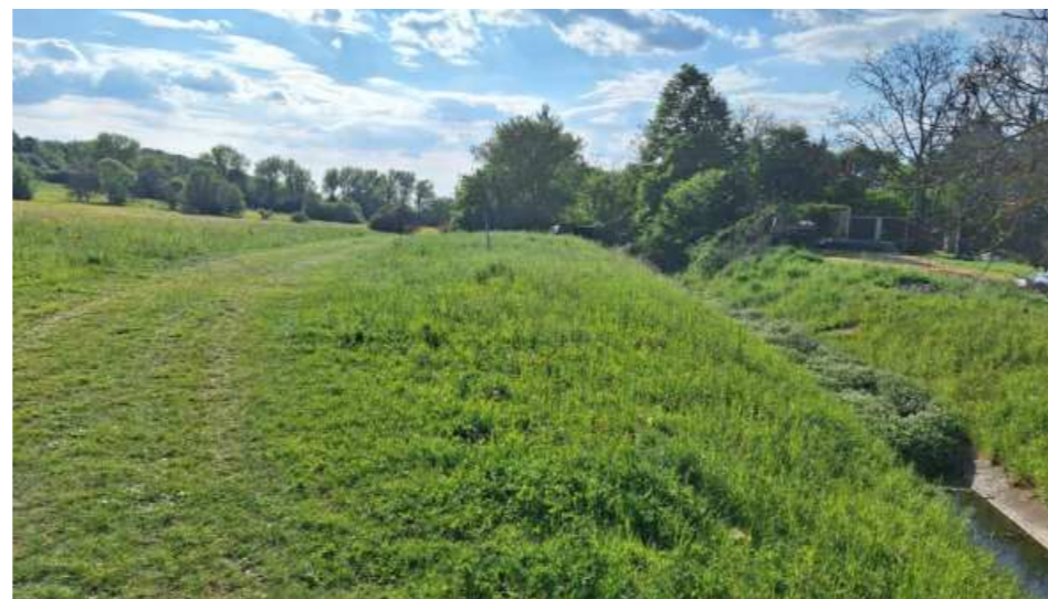
obr. 125: Podmáčená cesta podél betonového koryta ve východní části území vlastní foto
