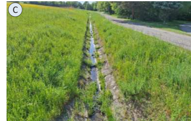
obr. 92: betonové koryto trativodu u studánky Pod Rozárkou vlastní foto
