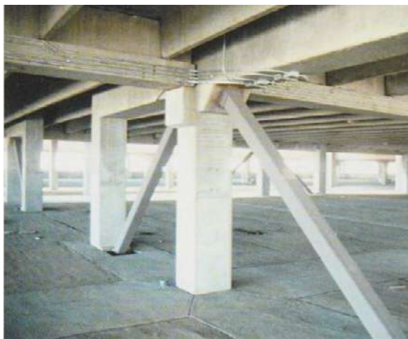
Obr. 29 - Mezinárodní letiště, Denver, Kolorádo, (1992) - kombinace oceli a betonu
