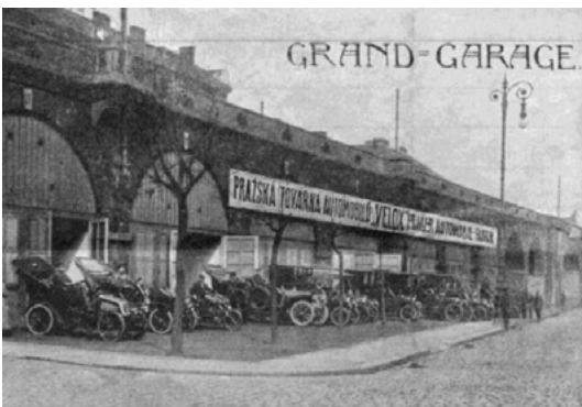
Obr. 67 - Garáže Velox v obloucích Negrelliho viaduktu
