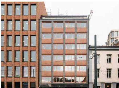
Obr. 58 - Spaces Tullinlokka, Oslo
