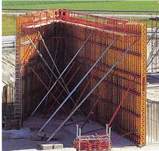
Obr. č. 3 Nosíkové stěnové bednění VARIO
