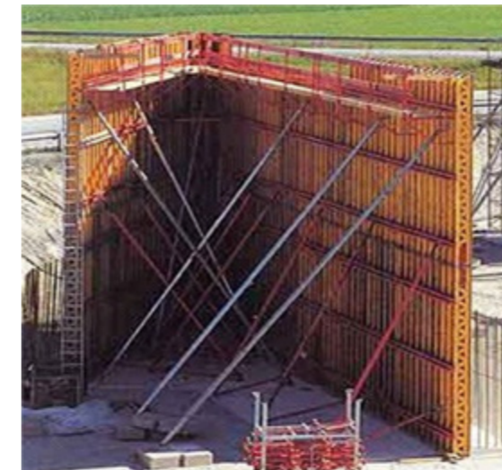
Obr. č. 3 Nosíkové stěnové bednění VARIO
