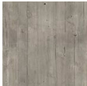
BETON nové stáje
