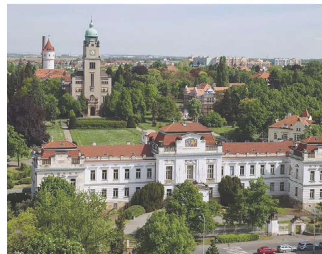
Současný stav - pohled na hlavní vstupní budovu
