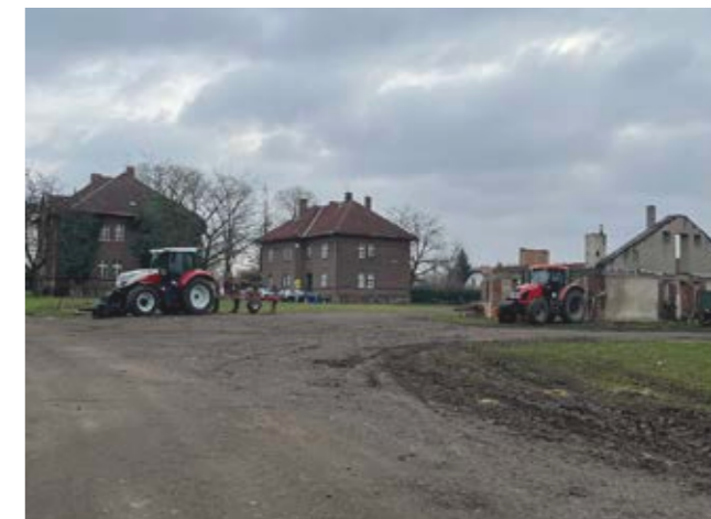
Administrativa a švejcárna
