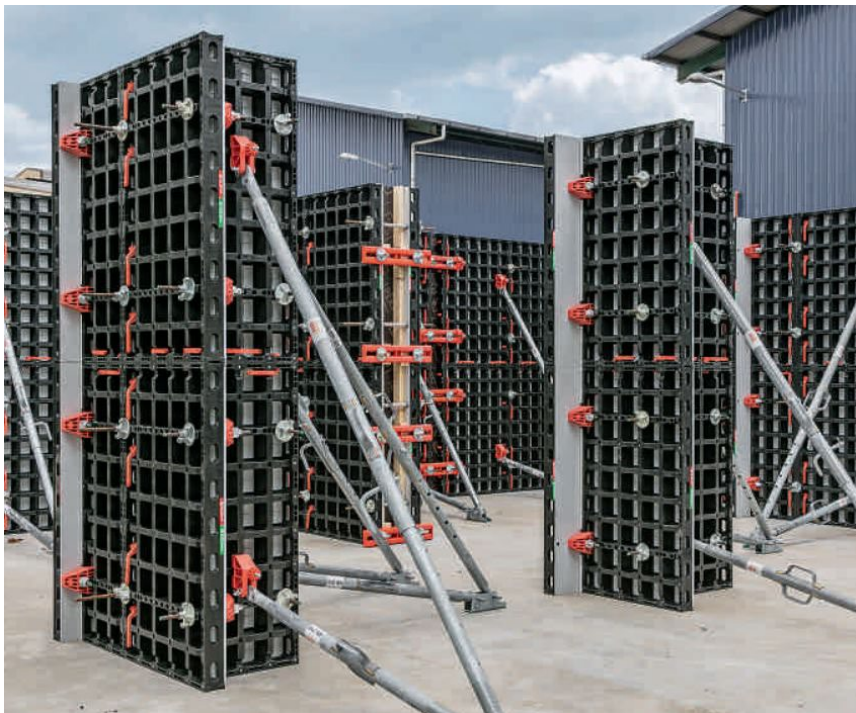
Obrázek 6: Systém bednění PERI DUO, ukázka provádění sloupů, PERI DUO brožura, 2017
