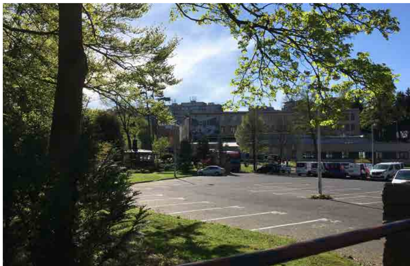
1 Pohled z ulice Zvolanská // Celý pozemek je uzavřený a oplocený. Parkoviště slouží také jako manipulační plocha provozu.
