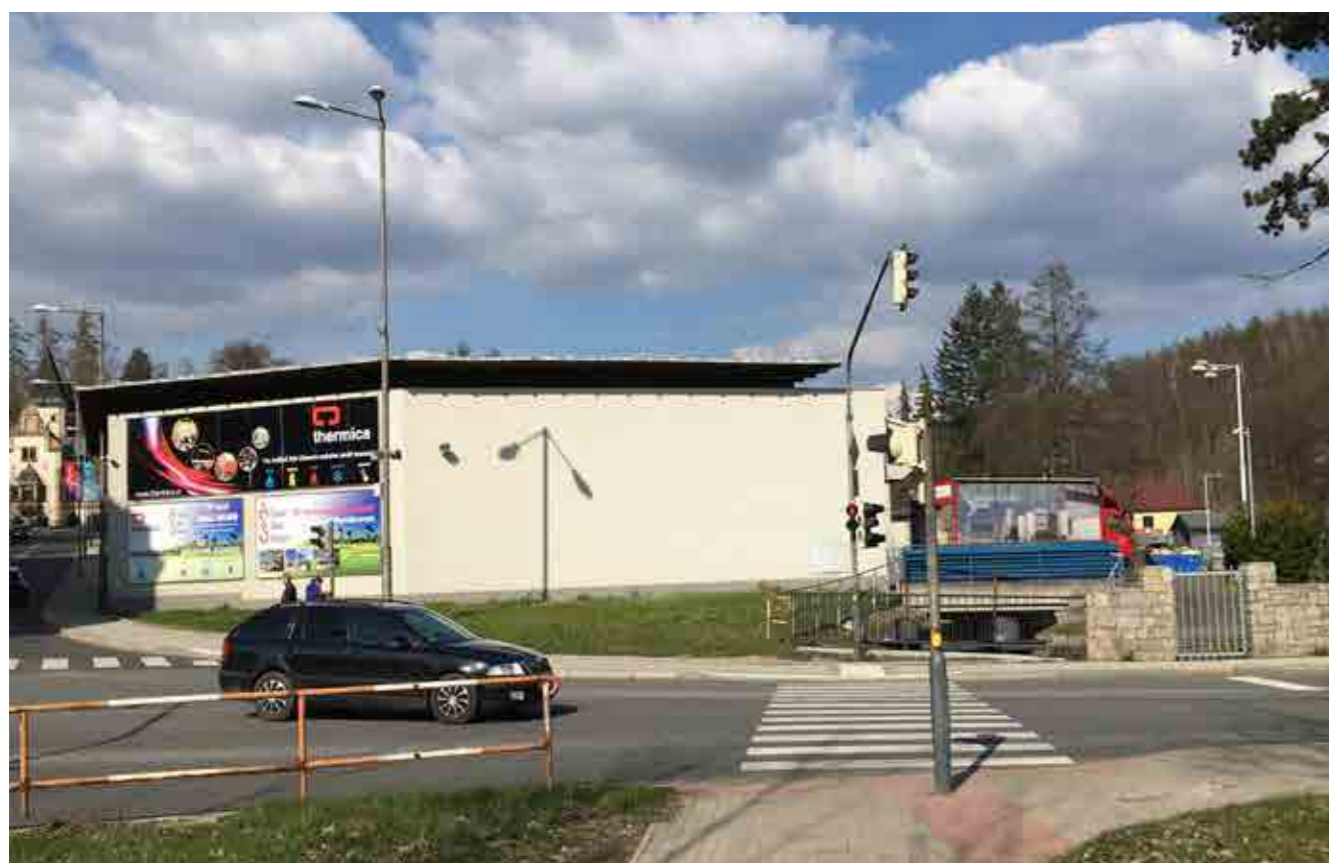
2 Pohled z křižovatky ulic Jablonecká a Na Bídě // Dříve objekt sloužil jako smíšený obchod Delvita. Dnes je to povozní objekt firmy Thermica.
