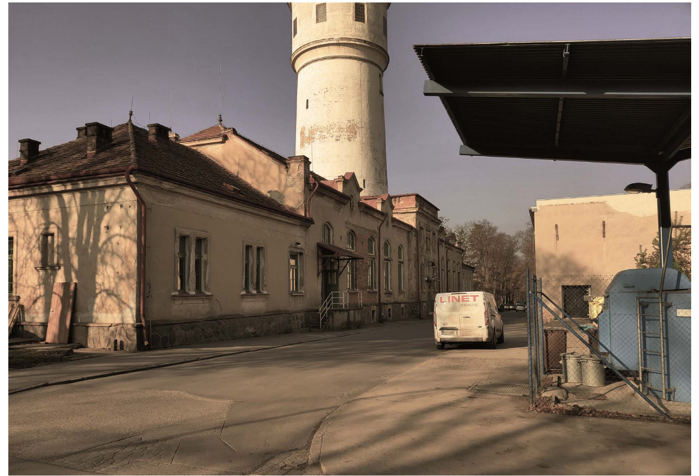
...a fasádou prádelny s vodárenskou věží...
