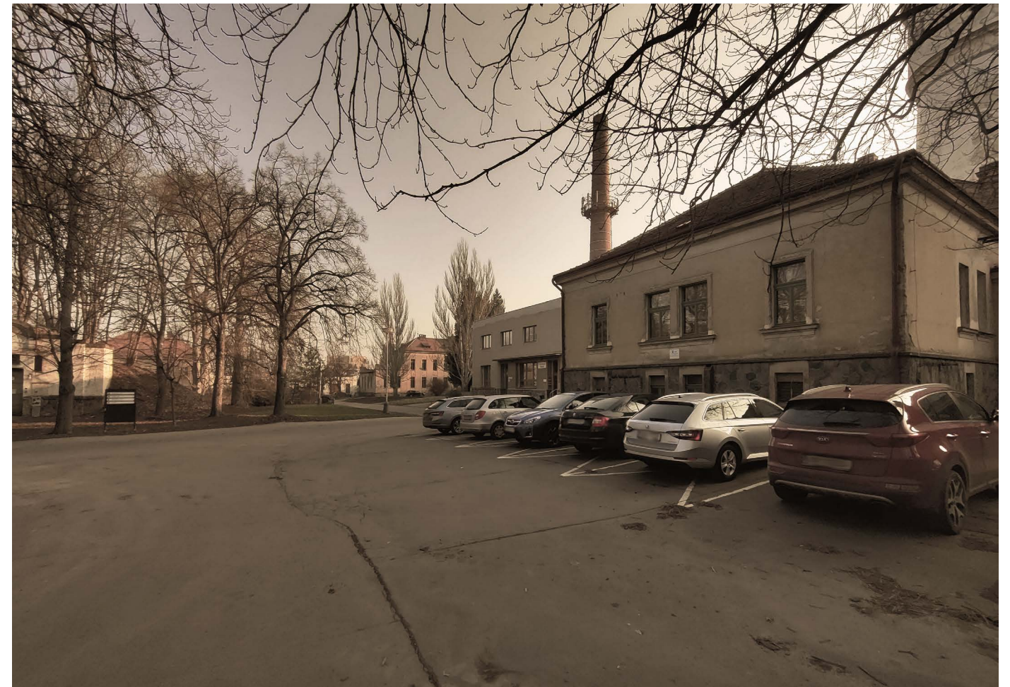
...ke staré prádelně a komínu kotelny...
