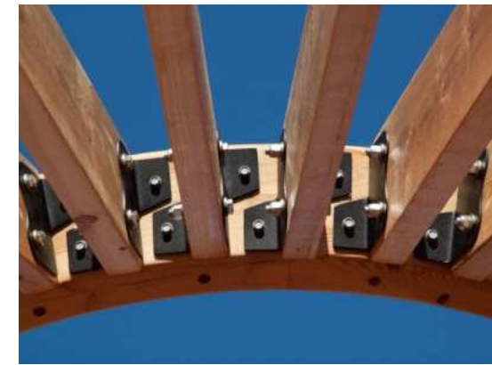
detail provedení spoje radiálních latí s obručemi
