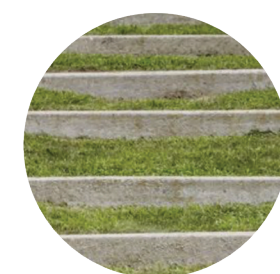
SCHODY V TRAVNATÉ PLOŠE
