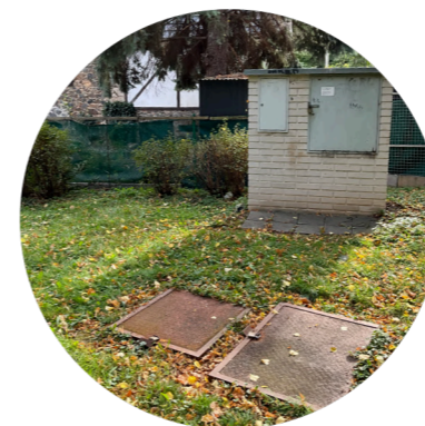
POKLOP PODZEMNÍ NÁDRŽE
