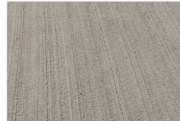
Struktura česaného betonu
