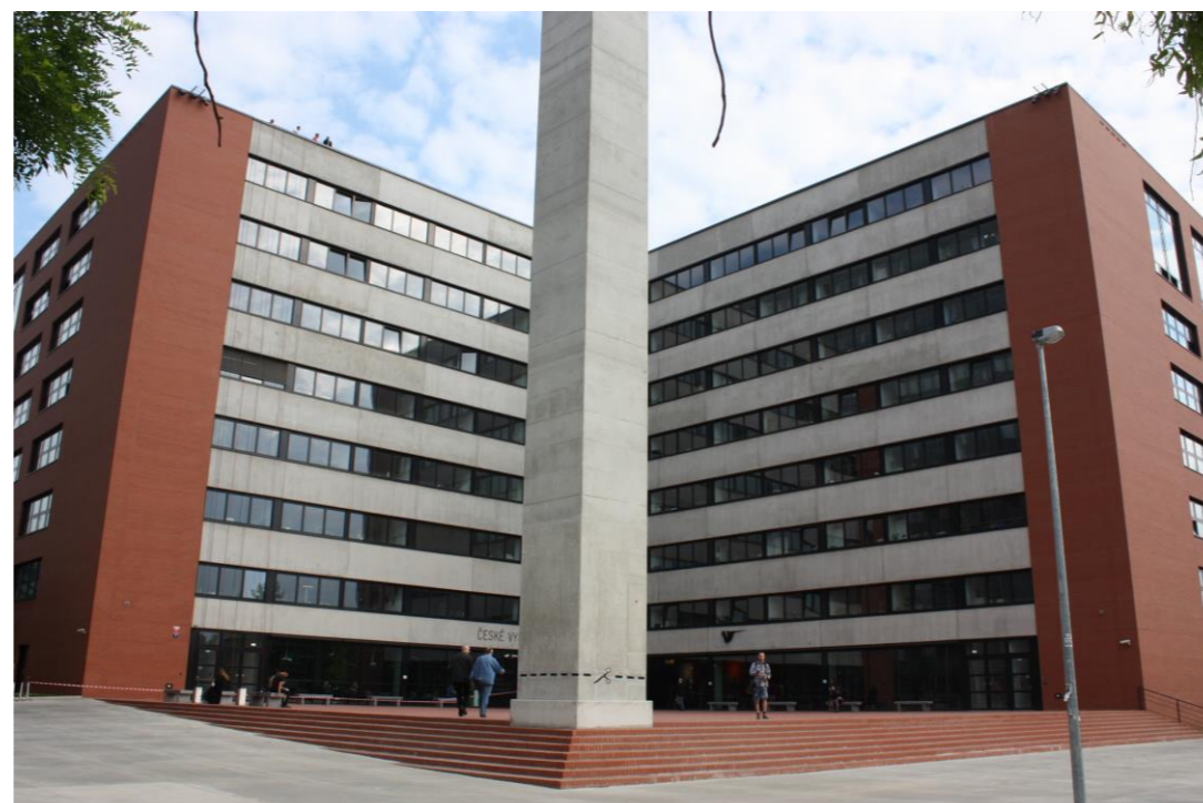
Nová budova ČVUT Praha (2005–2007)
