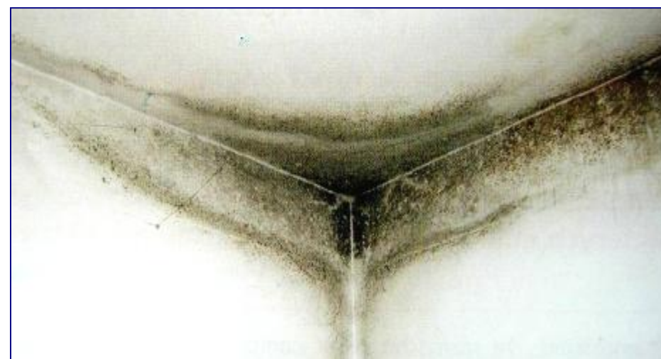
málo zateplený věnec stropu – místo vhodné k pěstování hub a plísní
